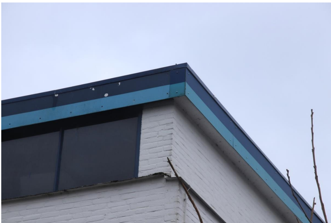
Foto 1: Dakbeschot is heel strak gemonteerd, zodat nergens geschikte invliegopeningen zijn
